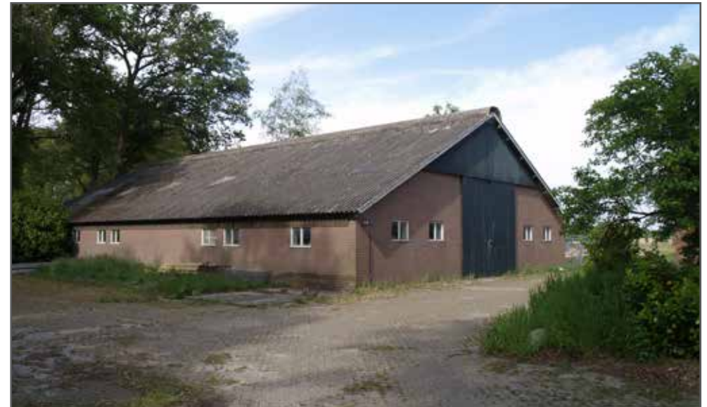
Afbeelding: Te slopen stal
