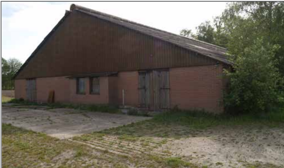
Afbeelding: Te slopen stal
