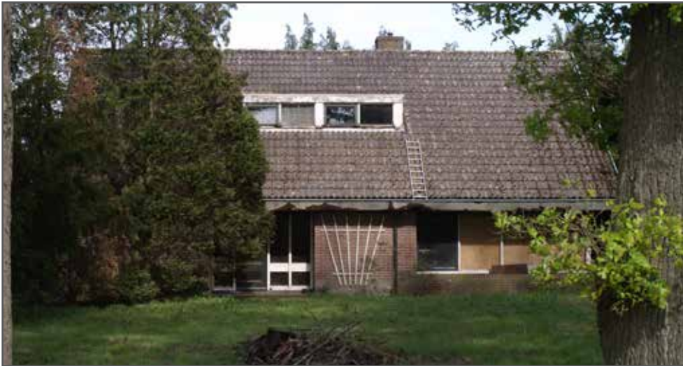
Afbeelding: Te slopen woning
