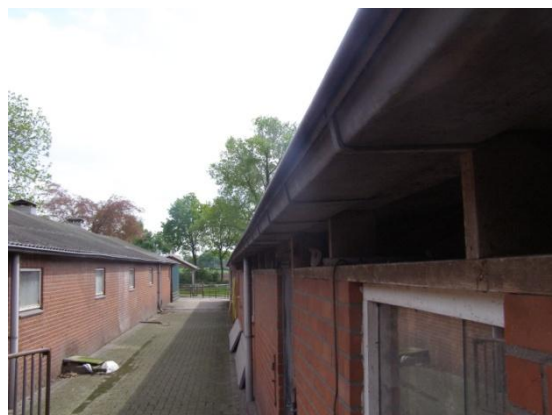
Afbeelding 4: de te slopen varkensschuren
