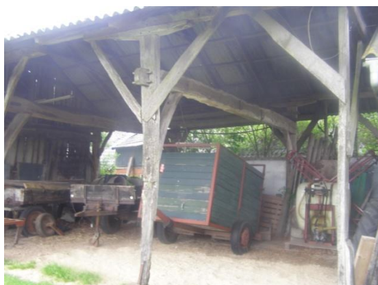
Afbeelding 5: de te slopen kapschuur
