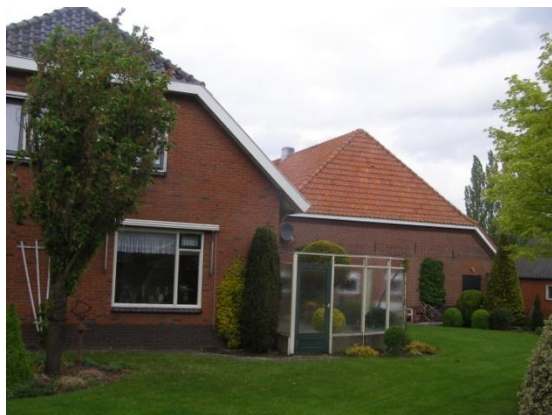
Afbeelding 1: voorzijde te behouden woning en schuur.
