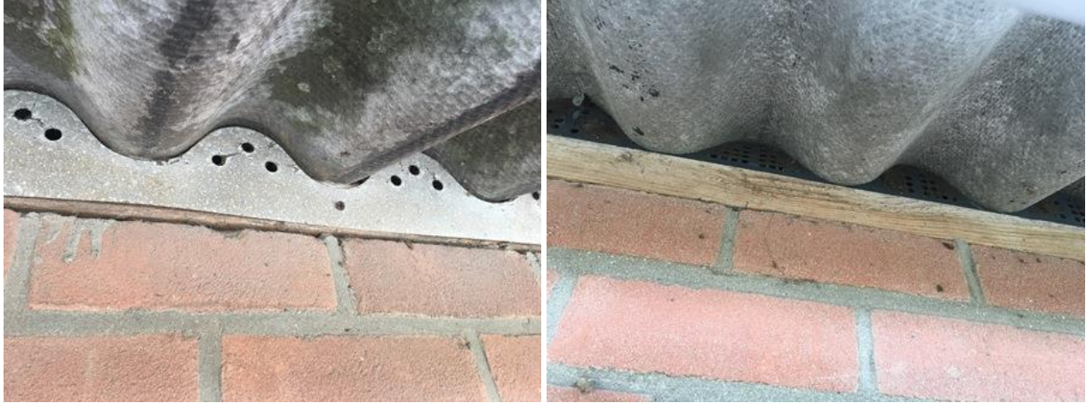
Afgedichte nokken van de golfplaten. Hierdoor kan de steenmarter (of een vogel) geen vaste rust- of voortplantingsplaats bezetten onder de golfplaten.
