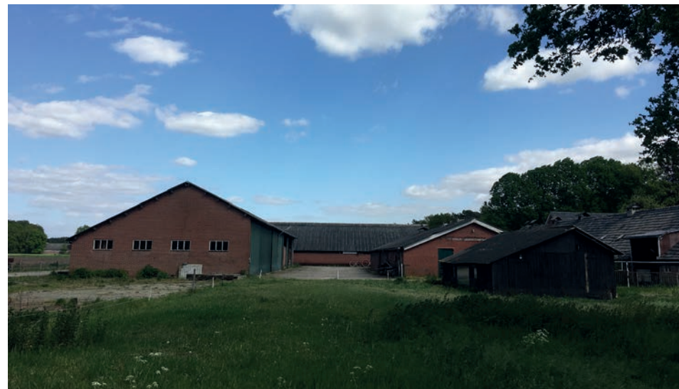
Afbeelding 5. Te slopen schuren
