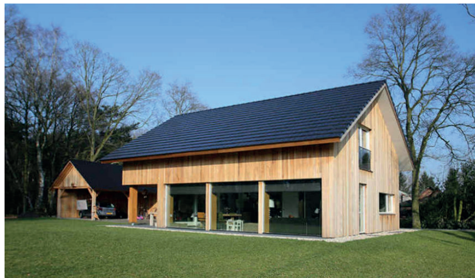
Afbeelding 50. Streefbeeld: bebouwing, woning.
