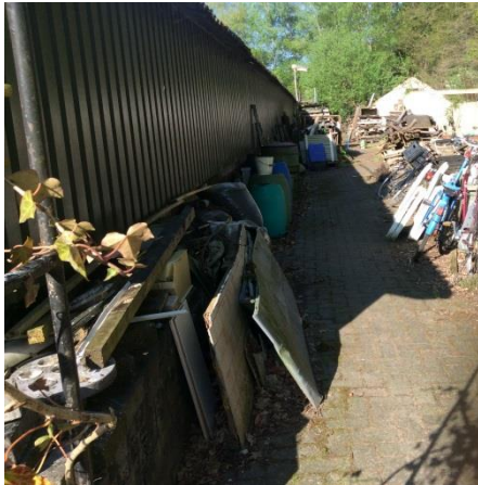
Figuur 8: Overzichtsfoto bebouwing
