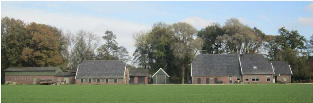
Figuur 2: Huidige bebouwing met bestaande karakteristieke boerderij en schuur: kijkrichting noord vanuit beek
