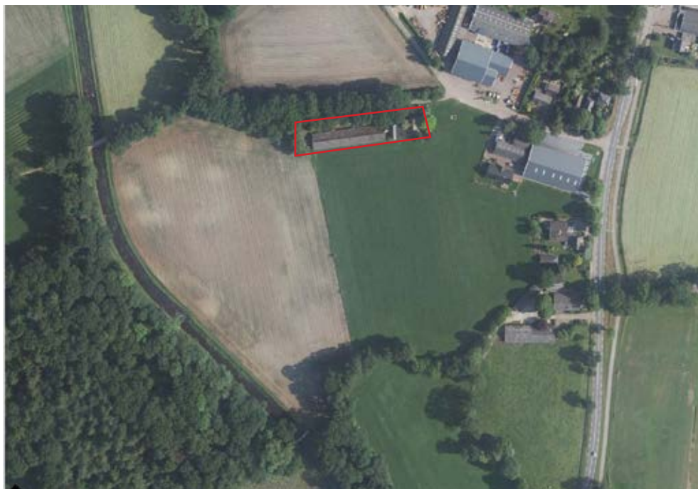
Afbeelding: Ligging van het perceel van de familie Raanhuis in het landschap. Aan de noordzijde de Eikenlaan. De schuur op de foto is de zuidelijke schuur en wordt gesloopt.
