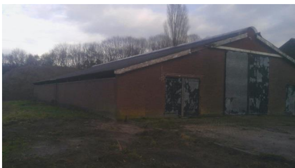
Figuur 8: Overzichtsfoto bebouwing
