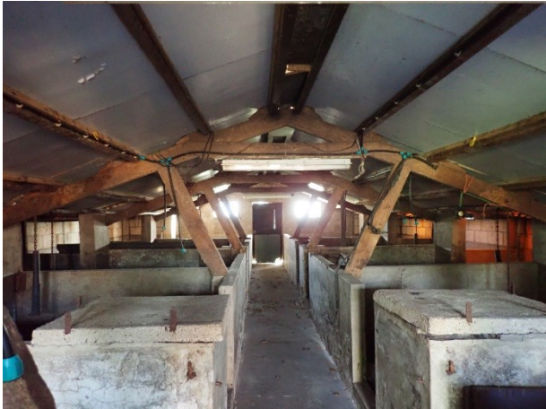
Foto 4: het interieur van de stal.
