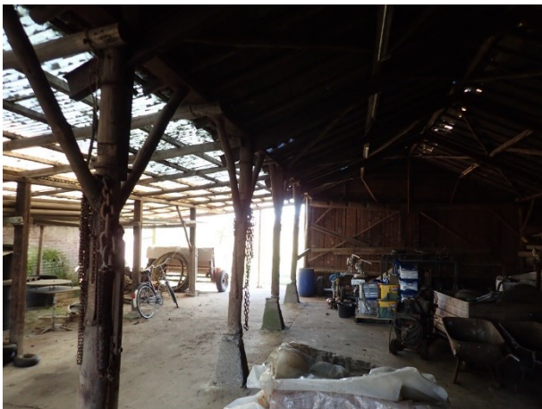
Foto 7: de verlenging van de oorspronkelijke kapschuur met een overkapping.
