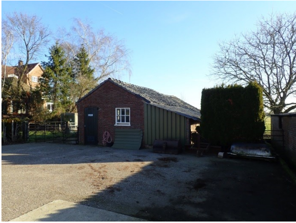
Foto 16: de te slopen varkensstal met het verharde erf.
