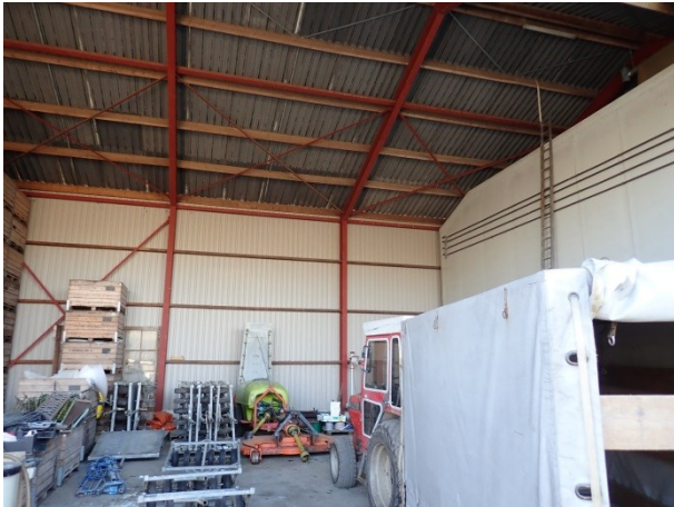
Foto 9: interieur met rechts een van de koelcellen
