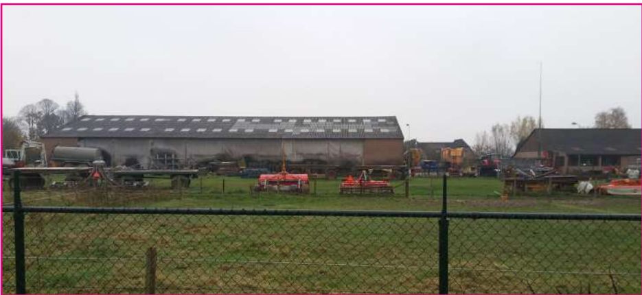
Te slopen gebouw
