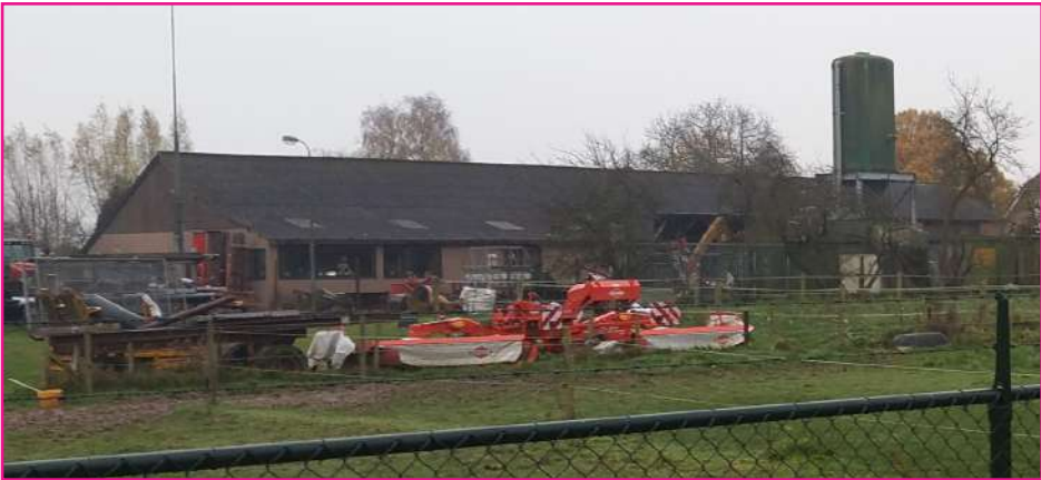
Deels te slopen gebouw
