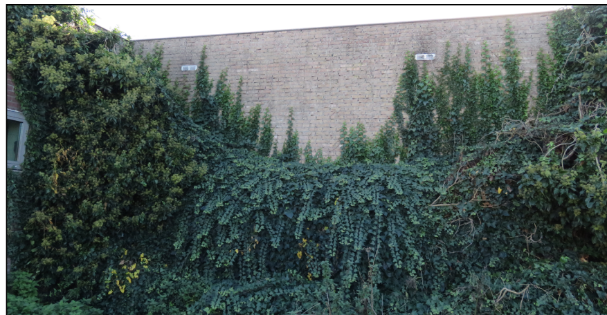
Figuur: een deel van de noordgevel van de Aldi supermarkt is begroeid met klimop. Hier kunnen vogels als merel broeden. Ook kan het onderdeel uitmaken van het functionele leefgebied van de huismus.
