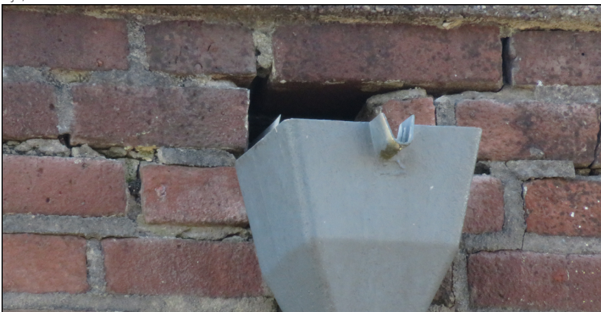
Figuur: bij de regenpijpen van de woning en winkel (nr 21 en 23) is ruimte aanwezig. Hier kunnen vleermuizen invliegen en verblijfplaatsen hebben in de spouwmuur. Ook kan de huismus hier broeden. De plekken zijn ongeschikt voor gierzwaluw, omdat een vrije aanvliegroute ontbreekt.
