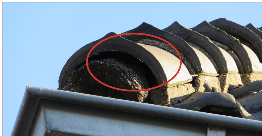
Figuur: onder een dakpan van de winkel (nr 33) is ruimte aanwezig (rode cirkel). Omdat een vrije aanvliegroute ontbreekt, is deze plek ongeschikt voor vleermuizen en gierzwaluw.
