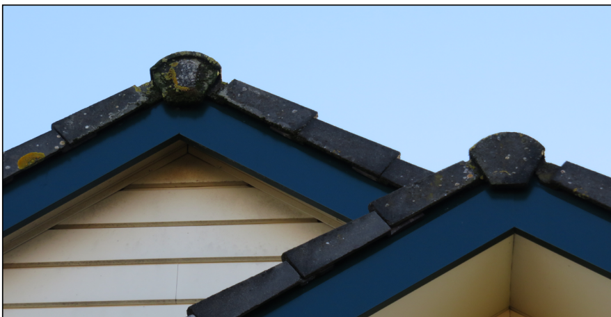
Figuur: achter de dakpannen van de woning ten zuiden van het plangebied is ruimte aanwezig. Hier kunnen vleermuizen verblijfplaatsen hebben. Deze verblijfplaatsen kunnen verstoord worden als er verlichting wordt geplaatst. Gierzwaluw kan hier broeden, effecten kunnen echter uitgesloten worden omdat de woning behouden blijft.
