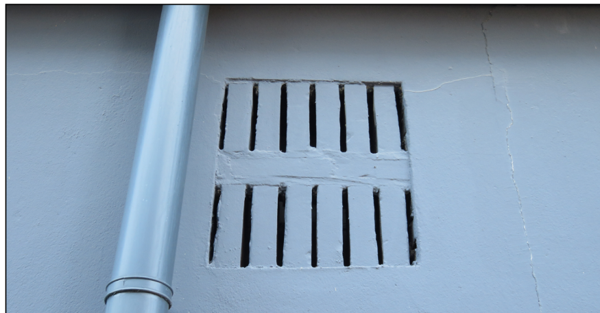
Figuur: in de ventilatiesleuven in de zuidgevel van de Aldi supermarkt kunnen vleermuizen invliegen en verblijfplaatsen hebben in de spouwmuur.
