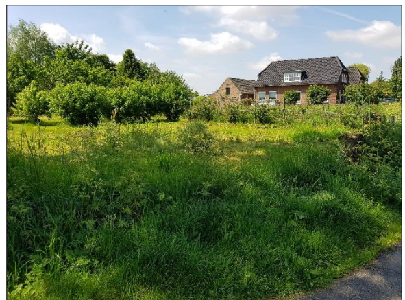
Figuur 9. Noordelijke perceel gezien vanaf noordoosten
