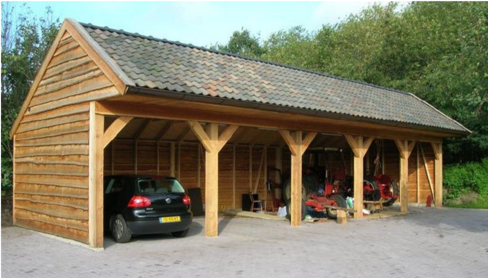
kapschuur met 'gebroken' kap
