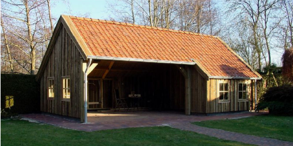
kapschuur van hout grotendeels open
