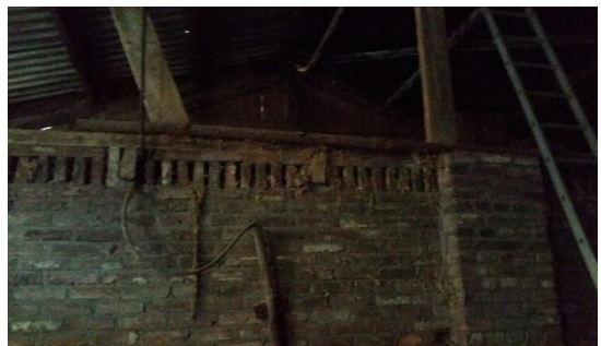
Afbeelding 10. Stal 1. Stenen kamer met houten dak. Bovenop is een hooizolder.
