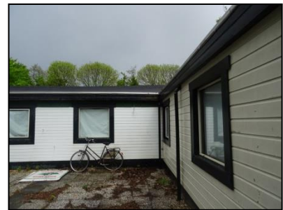
Figuur 5. Bijgebouw (gebouw 3).
