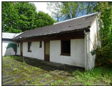
Figuur 4. Bijgebouw (gebouw 2).
