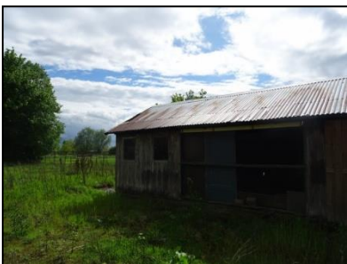
Figuur 6. Schuur (gebouw 4).
