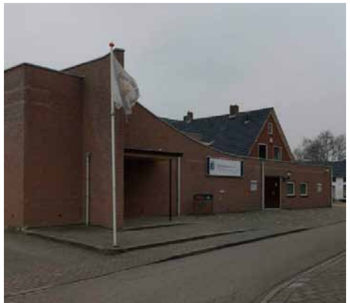
Bestaande aanbouw van Het Wapen van Valburg
