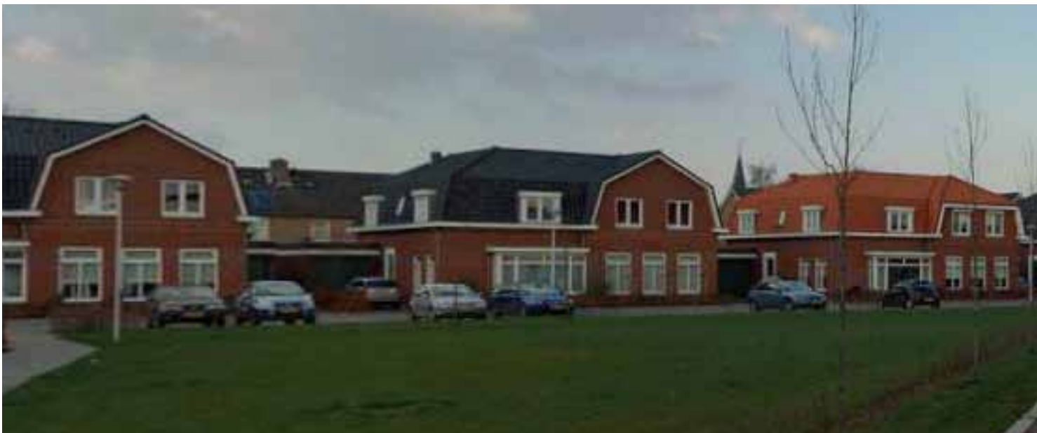
gerealiseerde bebouwing met een variatie in kapkleur
