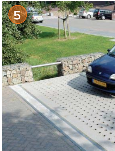
Overrijdbare wadi door middel van een duiker. (Bron: struykverwoinfra)
