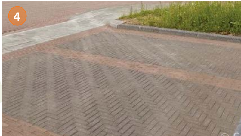
Rijbaan met een langsparkeerstrook in halfverharding, zonder verhoogde banden
