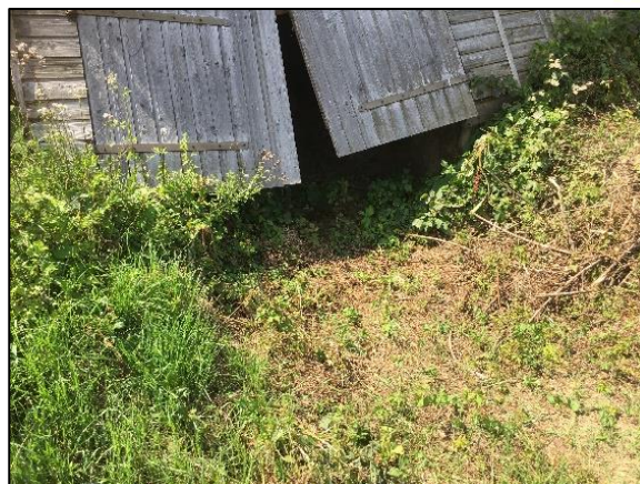
Foto 6. Toegang tot de schuur
