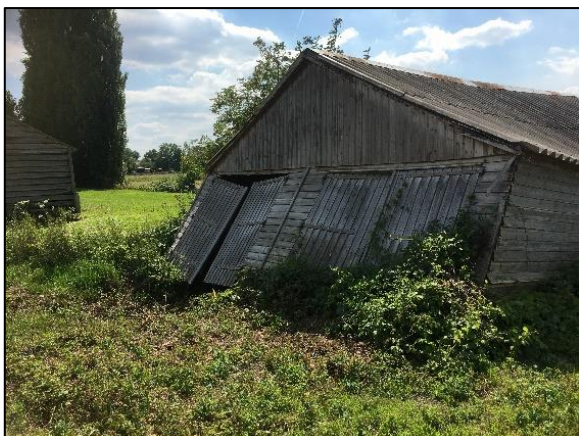
Foto 5. Schuur aan de oostzijde van het plangebied
