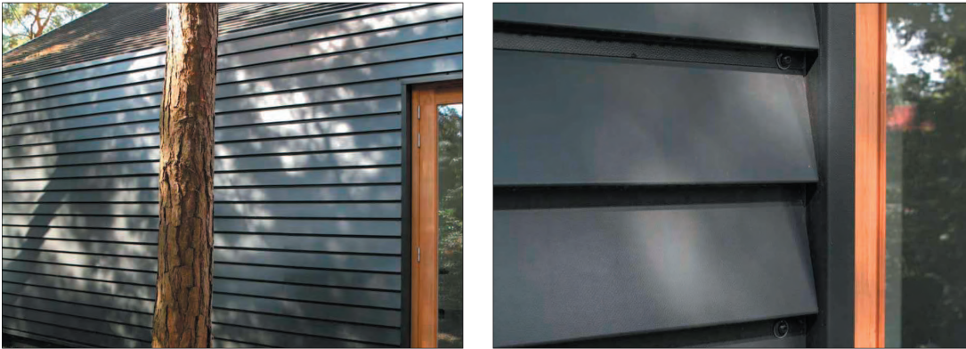
Figuur 5 en 6 voorstel gevelbeplating SAB potdeksel 22-500, kleur zwart
