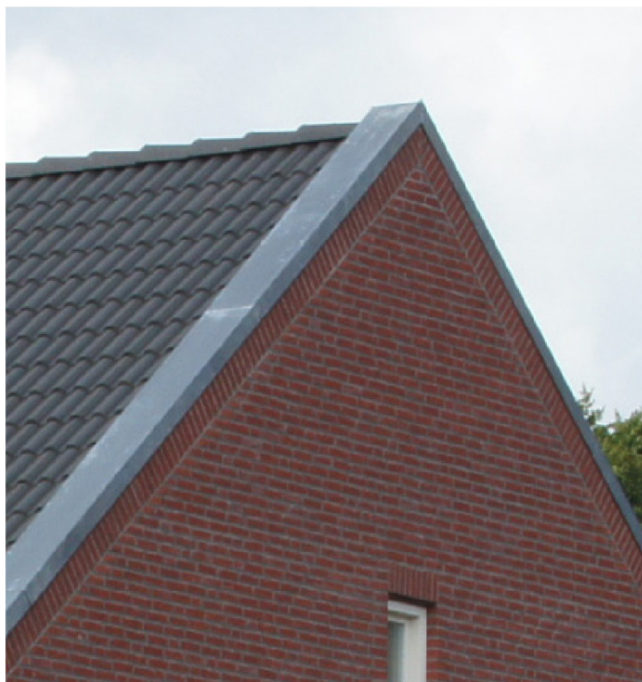
Eenvoudig metselwerkvolume met sobere detaillering
