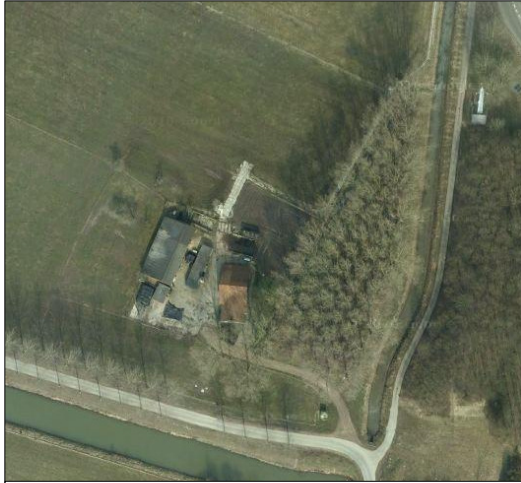
luchtfoto 1e Weteringsewal 21, Elst
