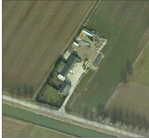
luchtfoto 1e Weteringsewal 19, Elst
