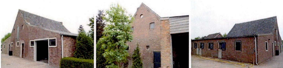
Foto's: De te slopen schuur en paardenverblijf.
