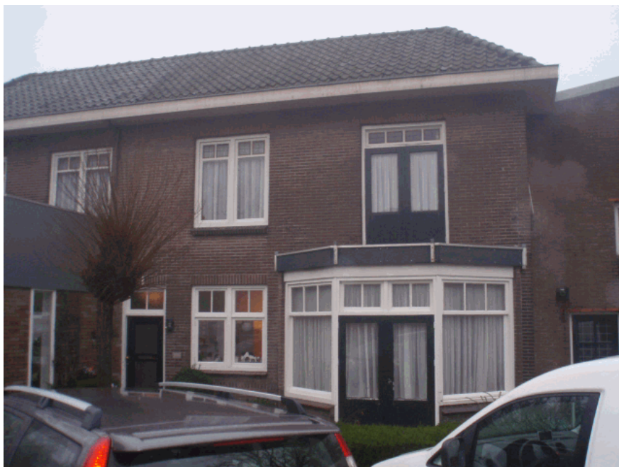
Aanzicht woonhuis Rijksweg zuid 1
