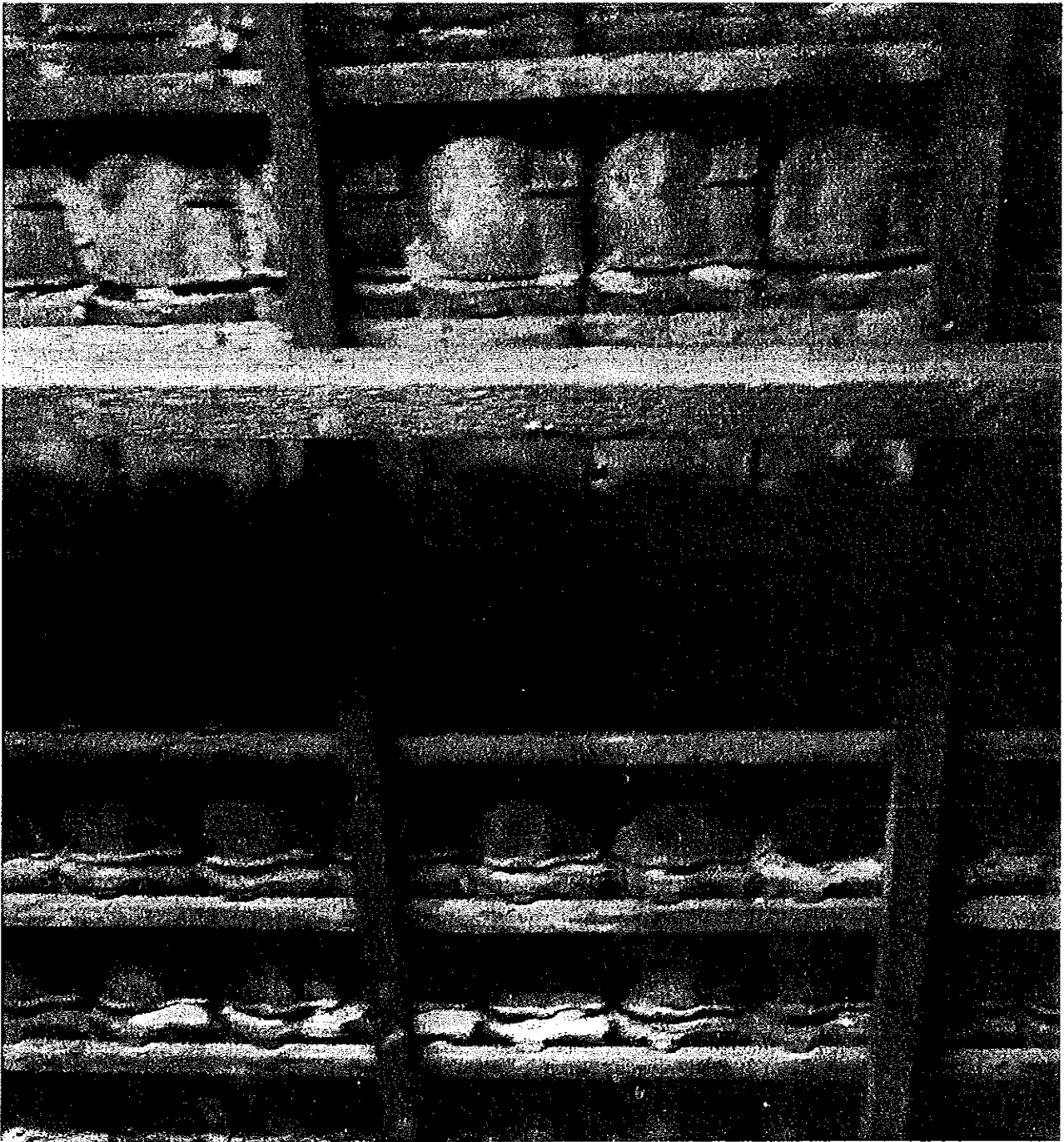
Binnenzijde van de enkelpannige dakbedekking op de zolder van peuterspeelzaal 'Krek Wak Wou' op de Schoutenkamp.
