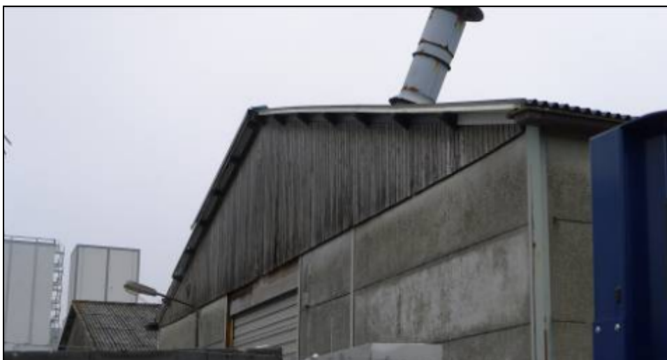
Figuur 3.2.4: Foto voor vleermuizen geschikte gevelbetimmering aan een bedrijfsgebouw in het plangebied.
