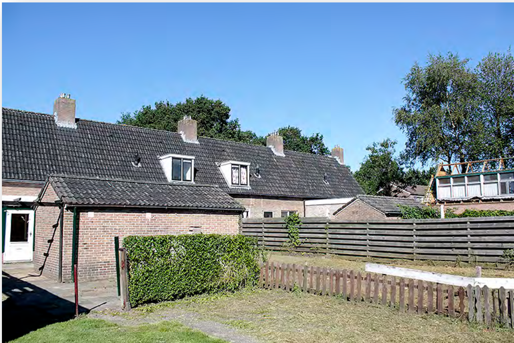
Plangebied, zicht in noordwestelijke richting
