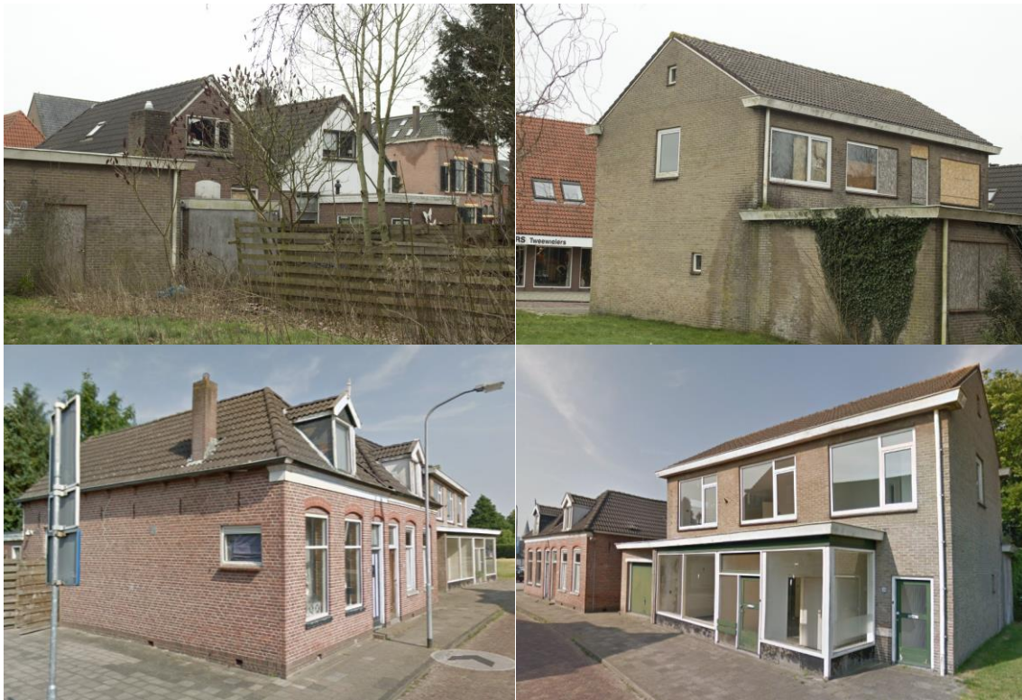
Detailopnames van het onderzochte gebouw aan de Hekstraat.
