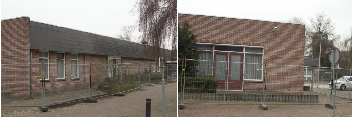
Detailopnames van het onderzochte gebouw aan Karspelstraat
