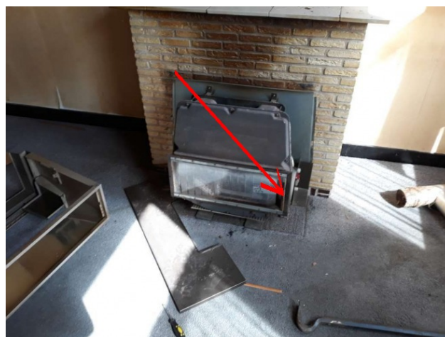
Foto 2: Situering MM7, koordafdichting gaskachel
