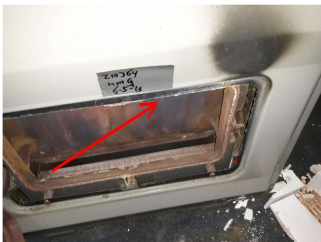
Foto 1: MM9, koordafdichting gaskachel keuken
