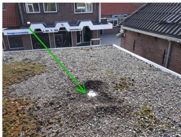
Foto 2: Situering MM3, dakbedekking
