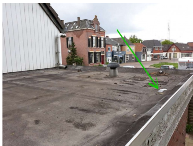
Foto 2: Situering MM13, bitumineuze dakbedekking
