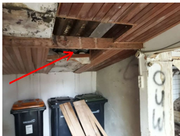
Foto 2: Situering MM12 golfplaten dak schuur
