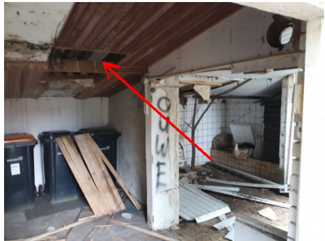
Foto 4: Situering golfplaten dak schuur
