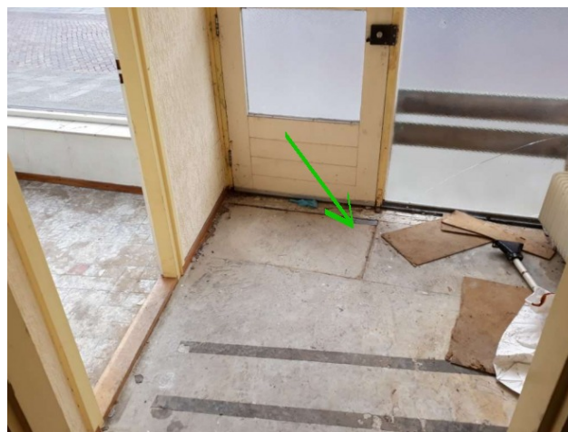
Foto 2: Situering MM1, plaat toegangsluik kruipruimte
