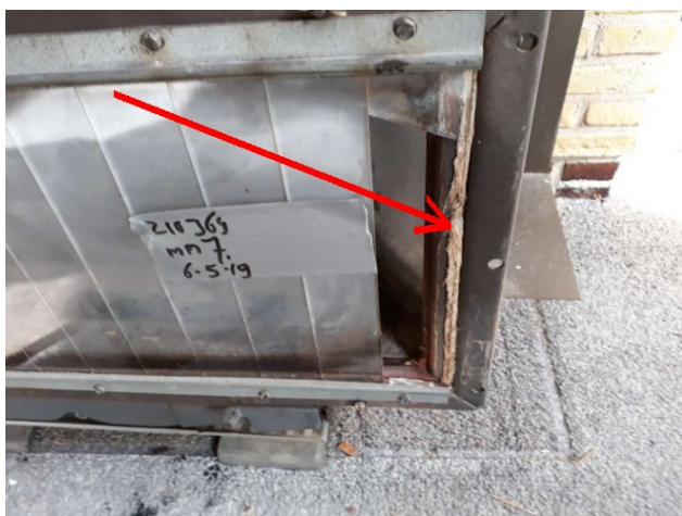
Foto 1: MM7, koordafdichting gaskachel
