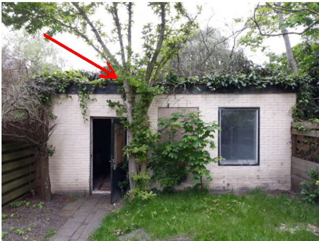
Foto 3: Situering golfplaten dak schuur
