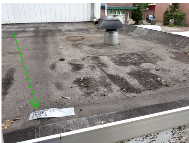
Foto 1: MM13, bitumineuze dakbedekking
