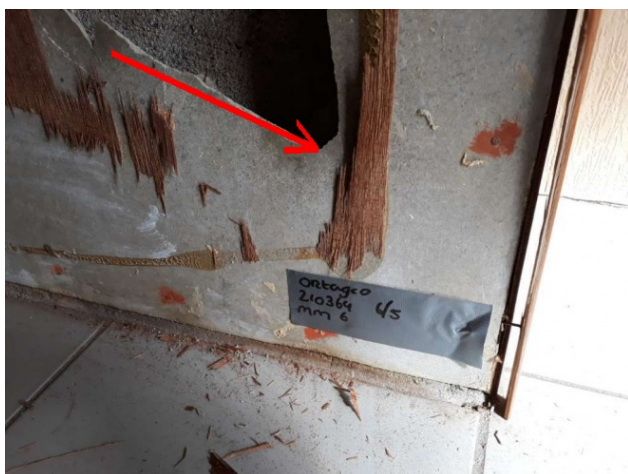
Foto 1: MM6, vlakke platen aftimmering boven gaskachel
