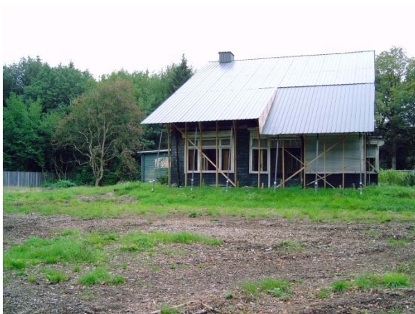
Foto 1 Zijaanzicht (westzijde) kampcommandantwoning (de serre, zie foto 3, is verwijderd)
