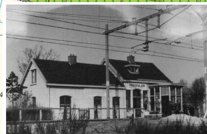
Station Hooghalen, na electrificatie in 1952, gesloopt in 1960
