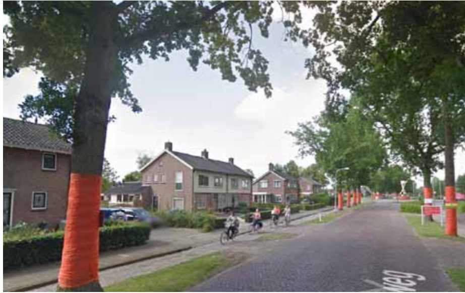
01. Twee-onder-één-kap woningen aan de Esweg
