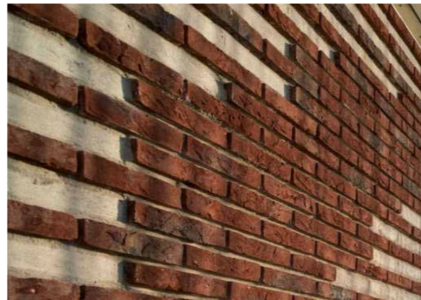
Chipperen metselwerk De terugliggende lijnen van de rijwoningen wordt uitgevoerd in licht grijs gechipperd metselwerk.
