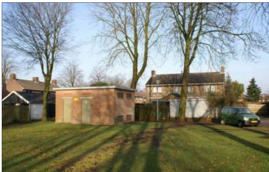
Het transformatorhuisje in het binnengebied (bron: DAAD Architecten)
