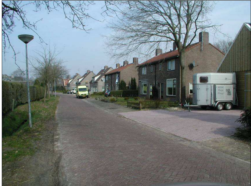
Twee-onder-een-kapwoningen aan de Tipweg
