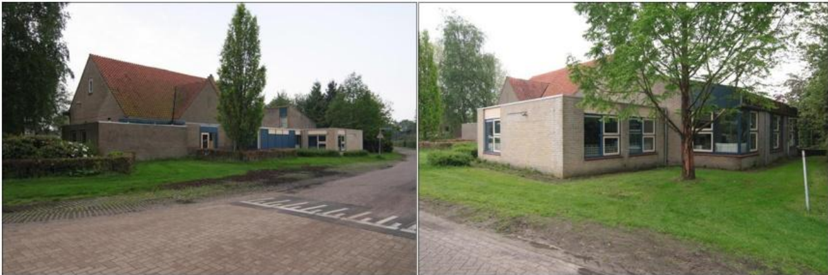
Afbeelding 2.4: Foto voormalig schoolgebouw (Bron: Funda/ Woonaccent Makelaars Westerbork)
