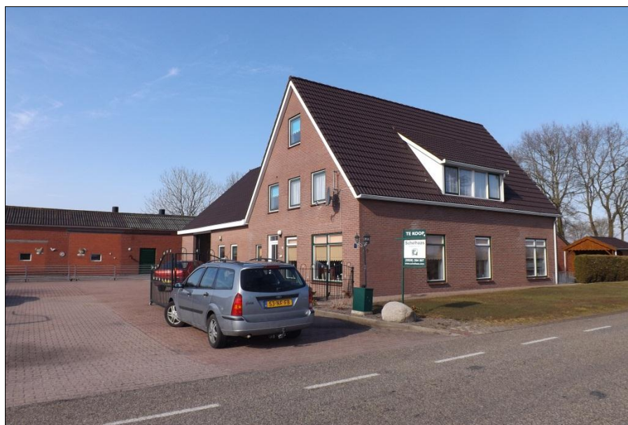
Erf met bebouwing vanuit het oosten
