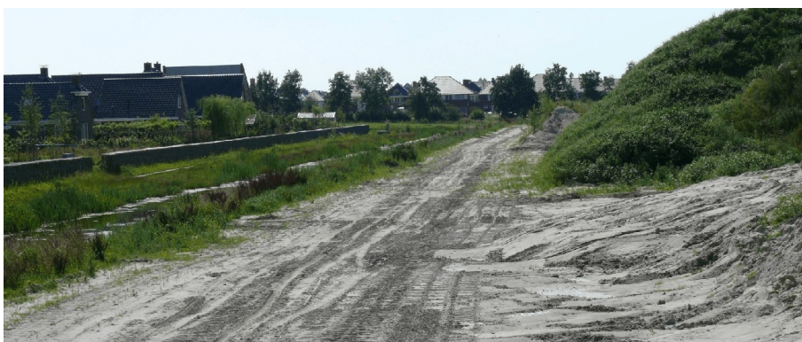
Figuur 2. Eelderwolde, Ter Borch. Op de bovenste luchtfoto is het plangebied rood omlijnd (Bron: Google Earth). Het al aangelegde wegcunet is in wit en met witte pijlen aangegeven, de gegraven en door ARCBv begeleide waterpartijen zijn met blauwe pijlen aangegeven. In oranje is de ligging van de metershoge zanddepots weergegeven. De zwarte pijl geeft de locatie en richting van de onderstaande foto weer. Op deze foto is de al aangelegde werkweg te zien.
