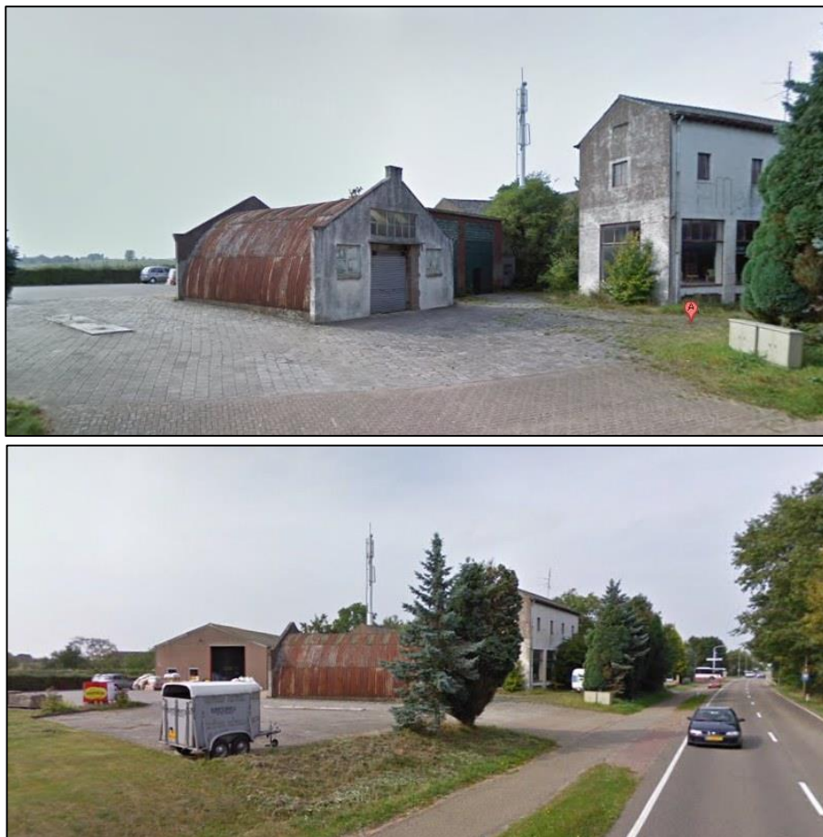
Foto's bestaande situatie
