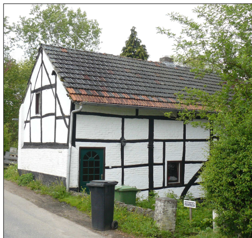
vooraanzicht (noord-oost) bestaande woning
