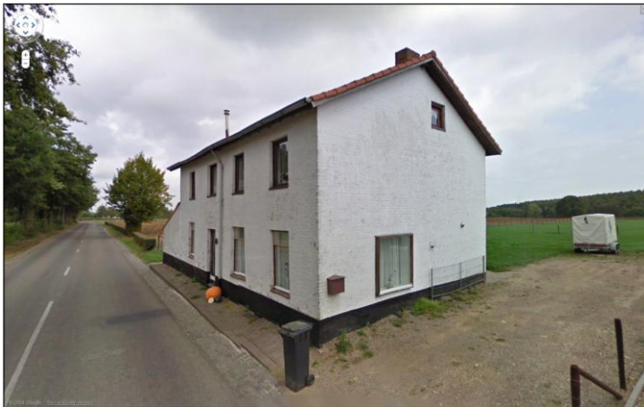
Figuur 4: bestaande woning
