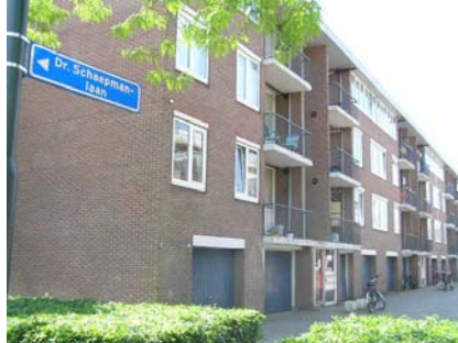
Appartementengebouw ten zuiden van het plangebied
