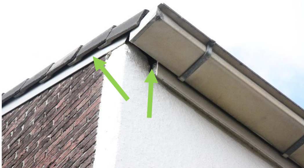
Foto 3: de bebouwing heeft meerdere openingen die geschikt zijn als verblijfplaats voor vleermuizen. Nadere inspectie leert dat deze openingen onvoldoende diep zijn en sterk onder invloed zijn van het klimaat, wat een instabiele (en daarmee ongeschikte) verblijfslocatie vormt.
