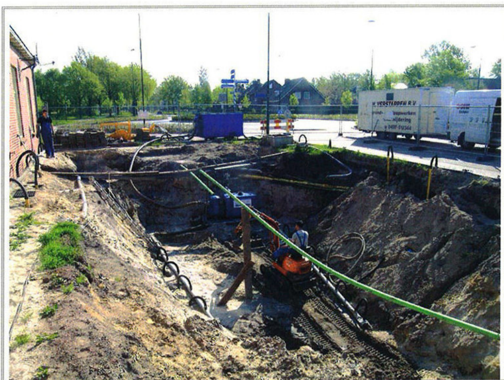
■ opschonen bodem na bijplaatsen 2e onttrekkingsring
