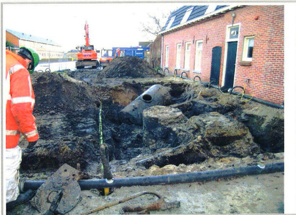
■ voorbereidende werkzaamheden; plaatsen bronbemaling, verwijderen olietank.
