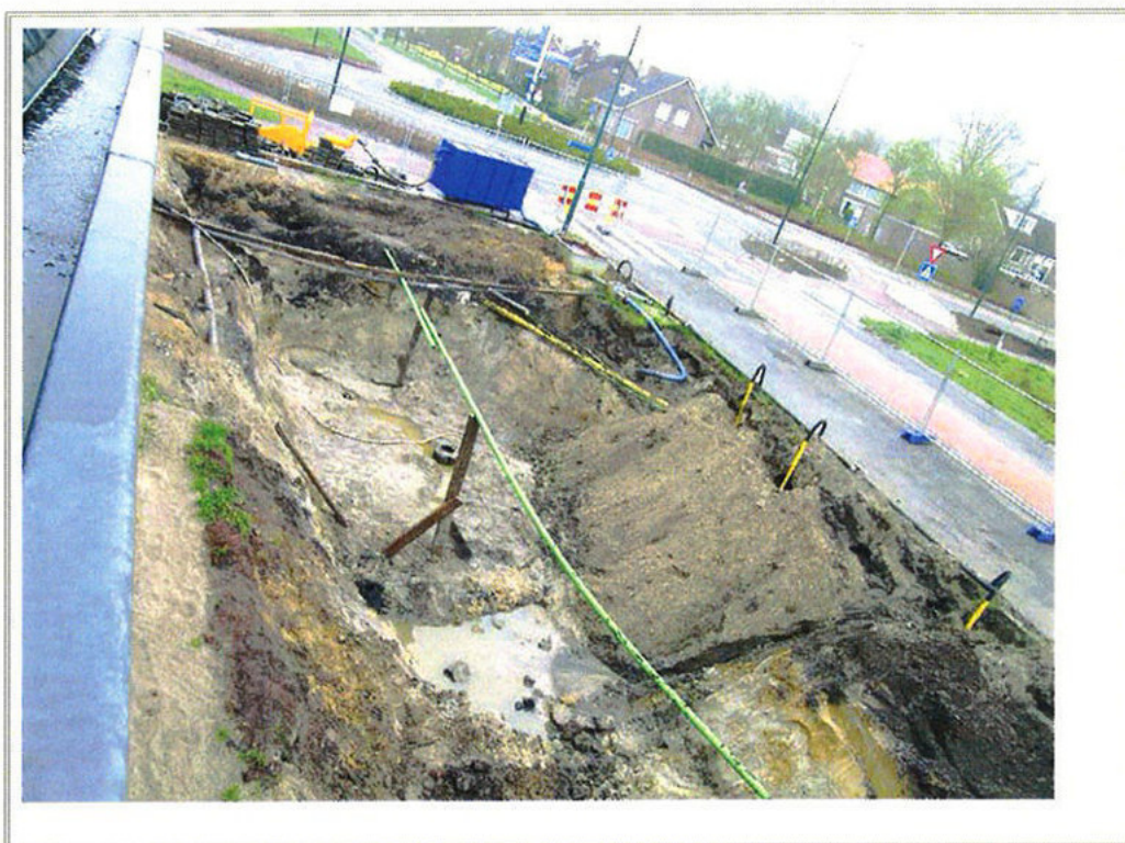
■ na ontgraving bij gasleiding direct stabilisatie v.d. wand
