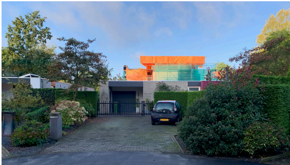
Afbeelding 21: door het toevoegen van een tweede bouwlaag is de privacy niet langer geborgd
