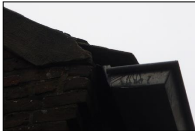
Figuur 13. Ruimte langs dakpannen welke toegang geven tot ruimte onder de dakpannen.
