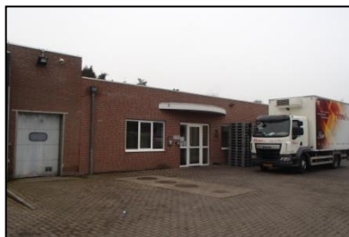
Figuur 7. Gebouw aan de noordwestzijde van de onderzoekslocatie.
