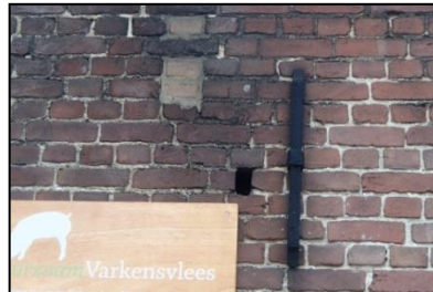
Figuur 14. Opening welke toegang geeft tot de spouwmuren.
