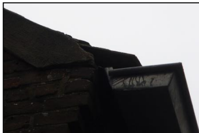
Figuur 10. Ruimte onder dakpannen, via de dakgoot bereikbaar.
