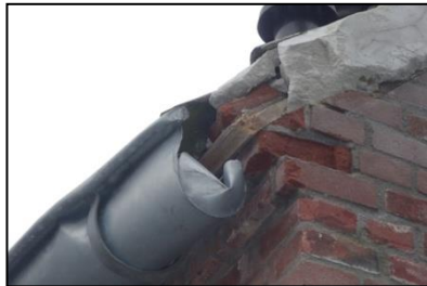
Figuur 11. Opening richting ruimte onder de dakpannen.
