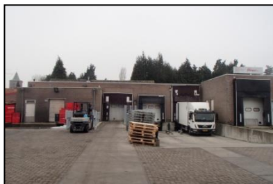
Figuur 6. Gebouw aan de noordwestzijde van de onderzoekslocatie.
