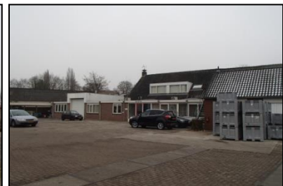
Figuur 5. Gebouw aan de oostzijde van de onderzoekslocatie.
