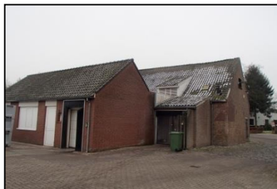
Figuur 4. Gebouw aan de oostzijde van de onderzoekslocatie.
