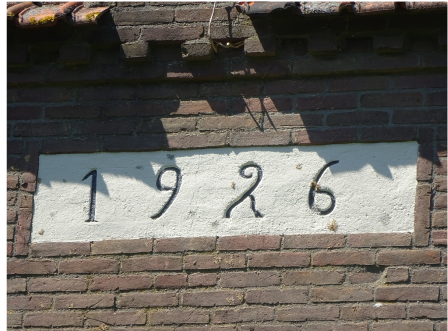
Figuur 13-Jaartalsteen van met de hand in het natte beton aangebrachte cijfers, 1926. Dit jaartal geeft niet het oorspronkelijke bouwjaar van de voormalige boerderij aan (dat ligt zo'n 25 tot 50 jaar eerder), maar het jaar dat de voorzijde van de boerderij en de linker zijgevel een ingrijpende verbouwing ondergingen.
