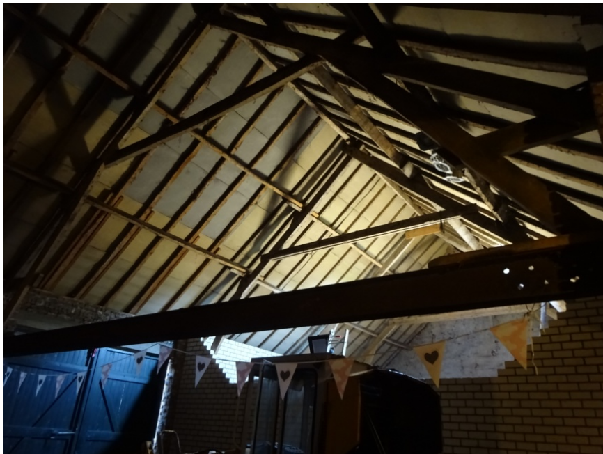
Figuur 12 - Sporenkap van het voormalig bedrijfsdeel.
