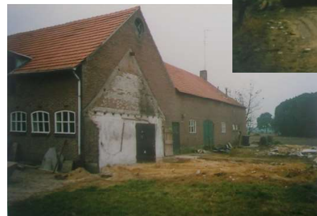
Boven en rechts: De schuurvleugel uit 1944 kort na de sloop.
