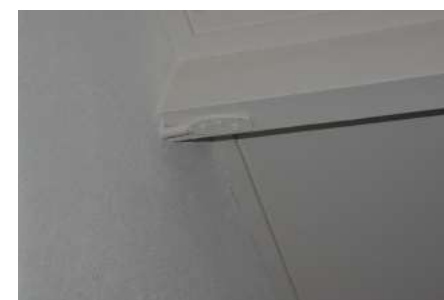
Een ijzeren koppelijzer bevestigd in de muur en ook tegen de gording.
