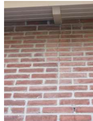
Bouwnaden tussen de geveldelen uit 1956 (links) en 1962 (rechts).
