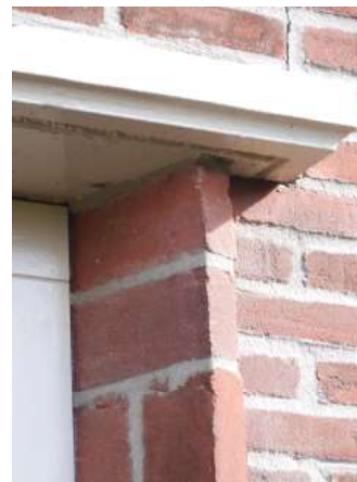
Bouwnaden tussen de geveldelen uit 1956 (links) en 1962 (rechts).
