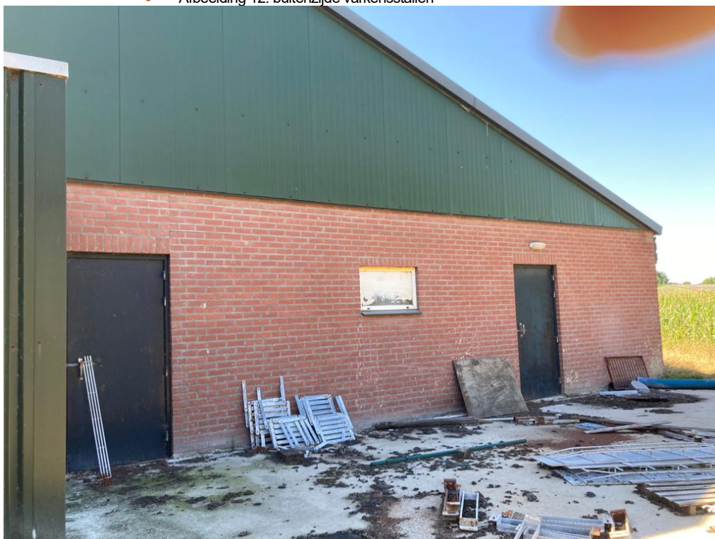
• Afbeelding 12: buitenzijde varkensstallen
