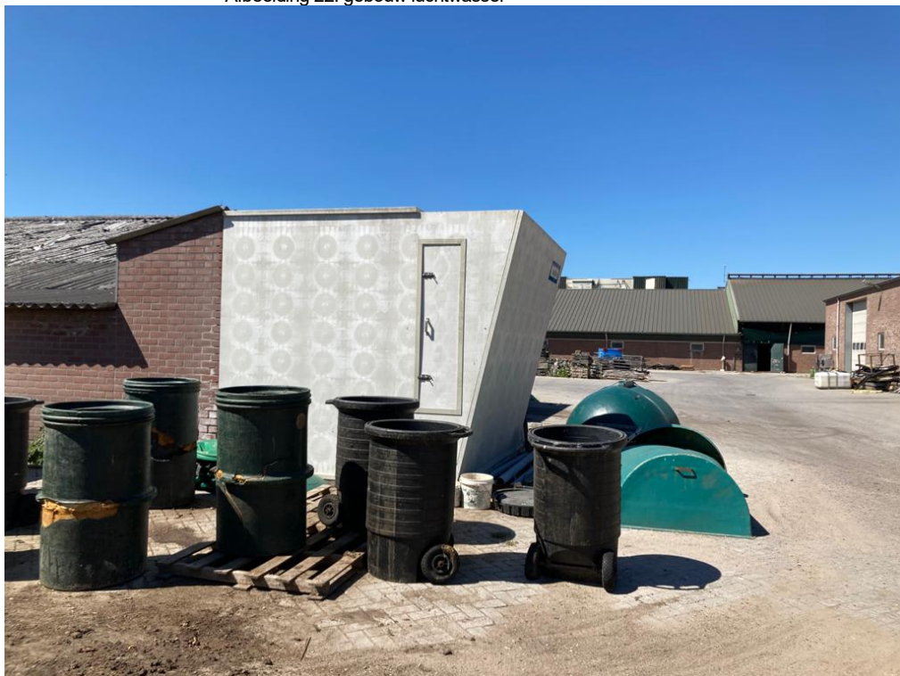
• Afbeelding 22: gebouw luchtwasser
