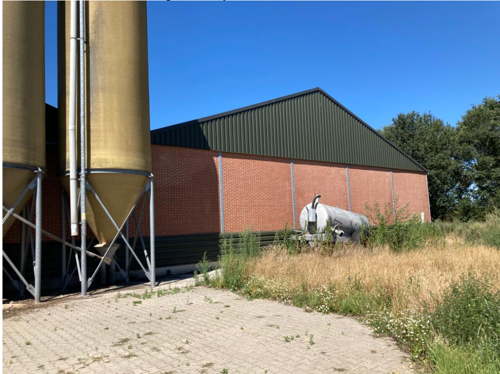
• Afbeelding 19: buitenzijde varkensstallen
