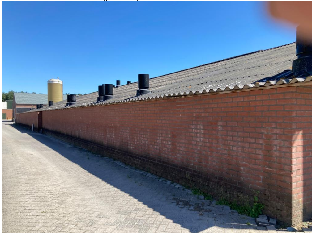
• Afbeelding 4: buitenzijde varkensstallen
