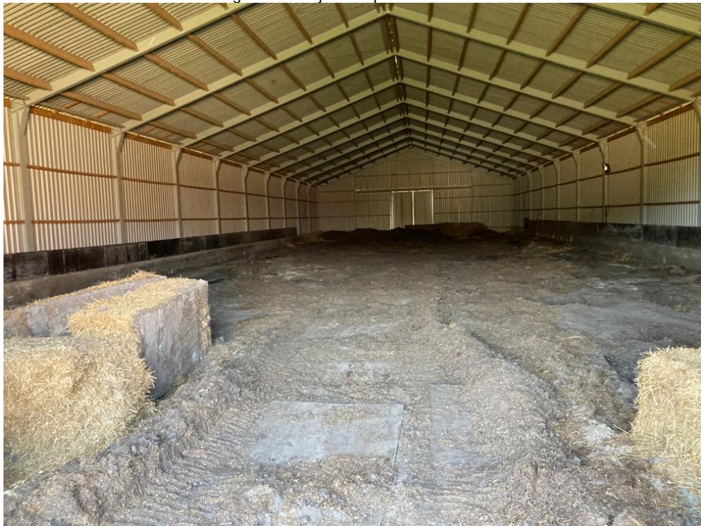
• Afbeelding 21: binnenzijde te slopen varkensstal
