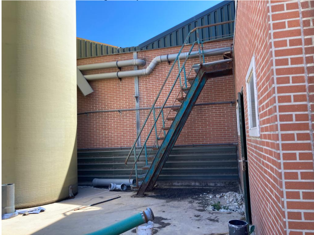
• Afbeelding 9: buitenzijde varkensstallen
