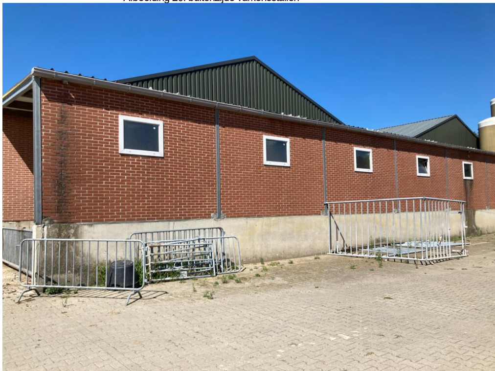
• Afbeelding 20: buitenzijde varkensstallen
