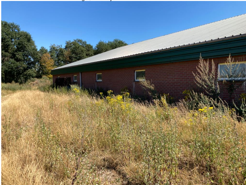
• Afbeelding 13: buitenzijde varkensstallen
