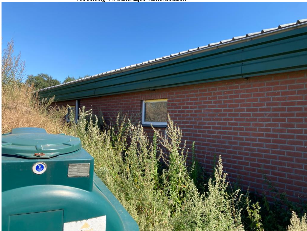
• Afbeelding 14: buitenzijde varkensstallen
