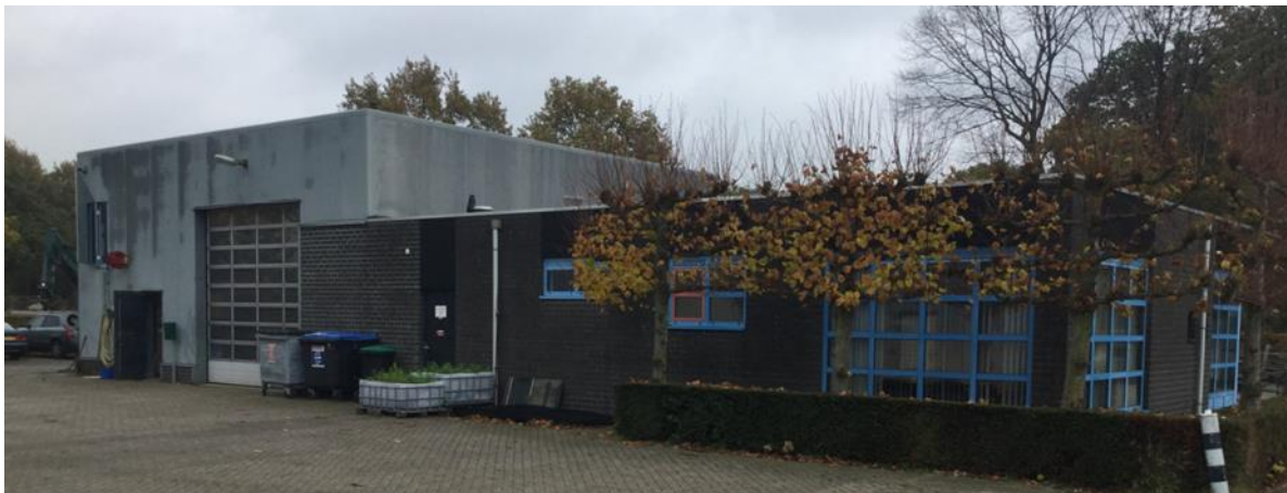
Figuur 2.2: foto impressie achterzijde bestaande kantoor en werkplaats
