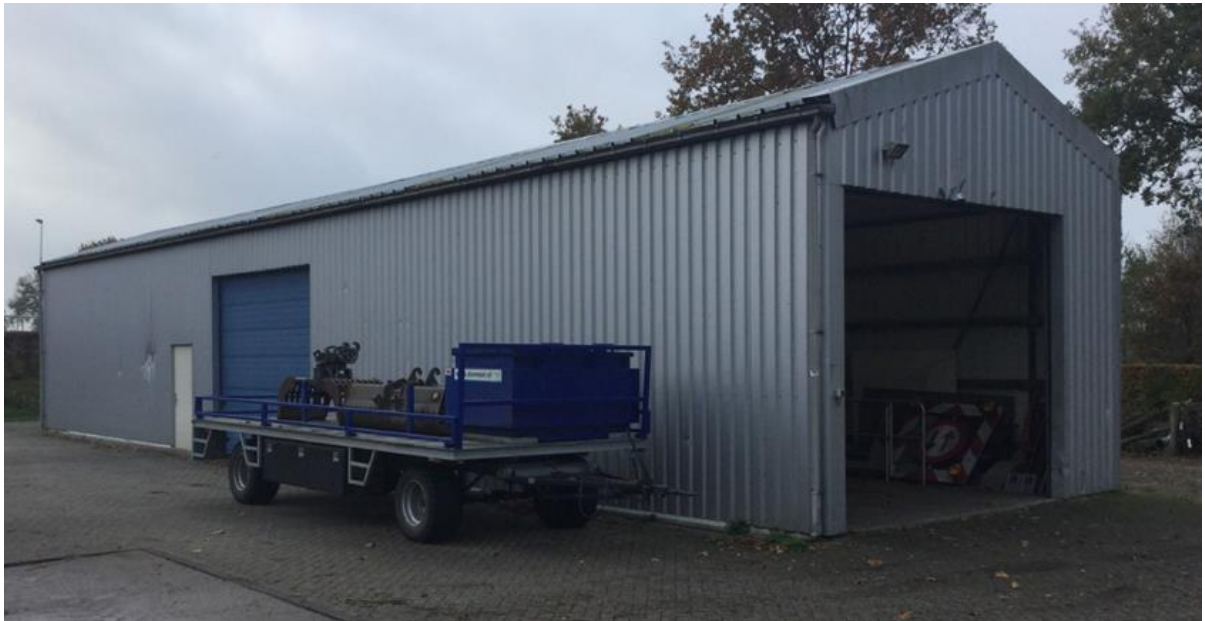
Figuur 2.5: foto impressie bestaande (te slopen) loods
