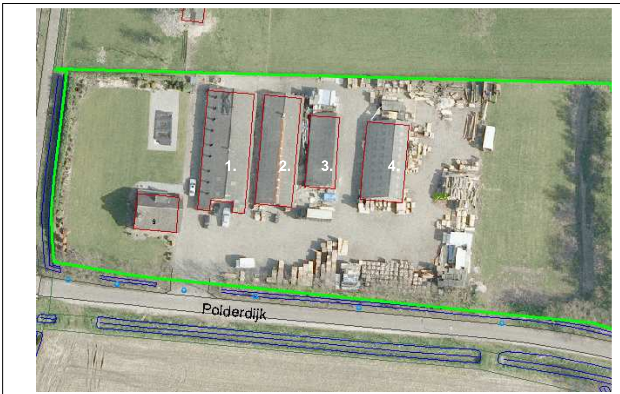
Figuur 2: overzicht bestaande situatie Polderdijk 9.
