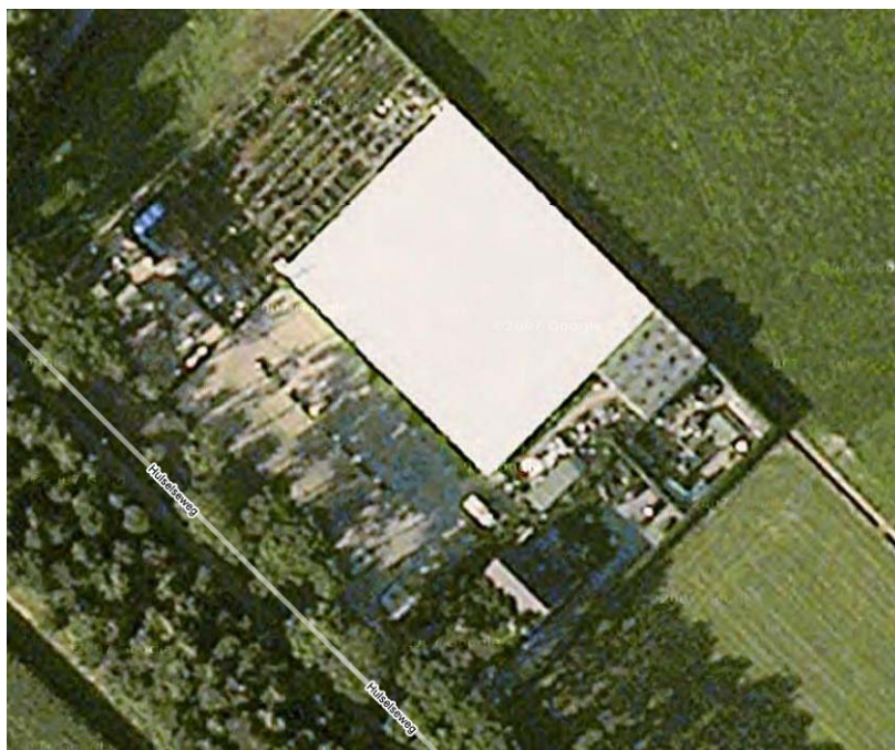
Luchtfoto van de projectlocatie en de directe omgeving
